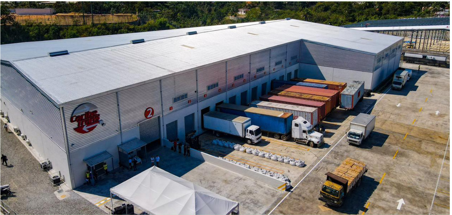
Inauguración del nuevo depósito logístico de Caribetrans situado en San Cristóbal.
